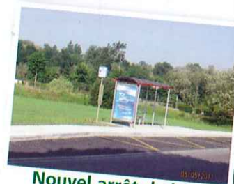
Nouvel arrêt de bus Près du rond point de l'Aussonnelle
