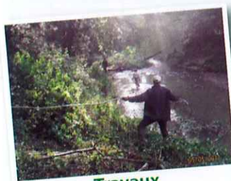
Travaux sur l'Aussonnelle
